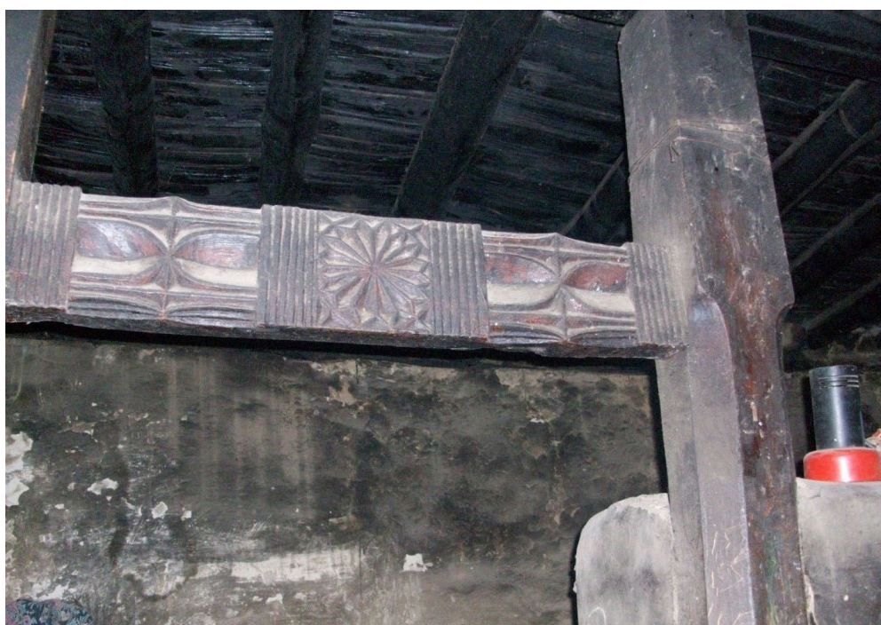
Фото 8 и 9. Вишкіўтj – балка между двумя столбами в традиционного памирсого дома (первая в доме новой постройки, а вторая в доме старой постройки)
