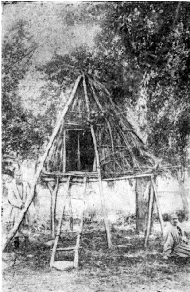
Рис. 132. Летнее сооружение на сваях для спанья в с. Сытарг в Язгулеме.
