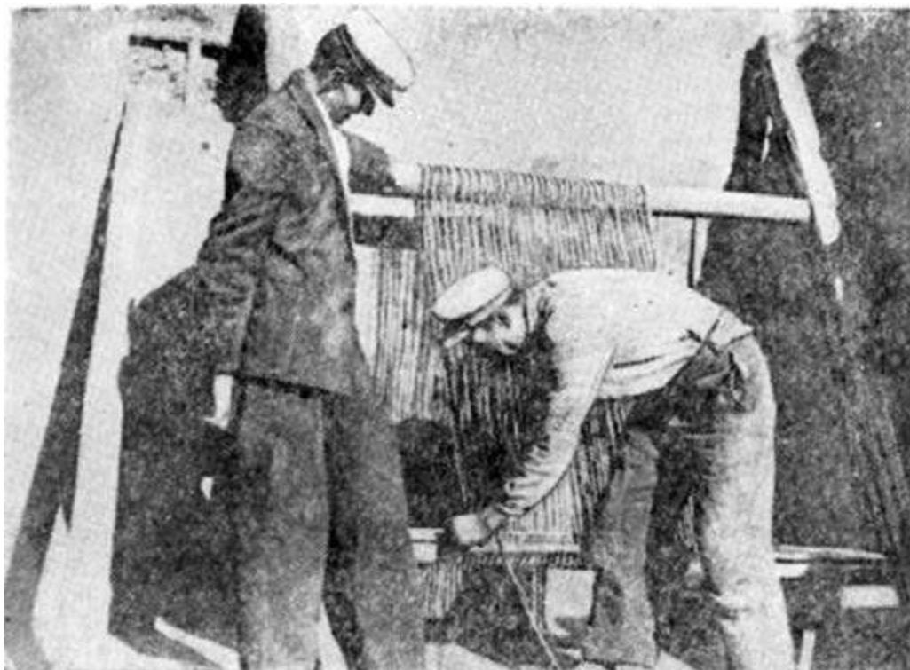
Рис. 77. Наматывание основы и вертикальный ткацкий станок.
