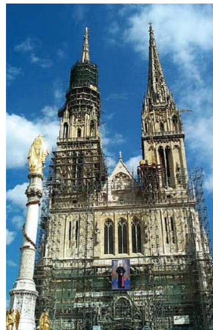
Готический кафедральный собор Загреба во время реконструкции
