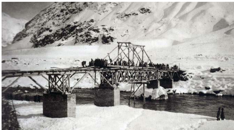
Строительство первого инженерного моста через реку Гунт. Хорог. 1909 год. 172
