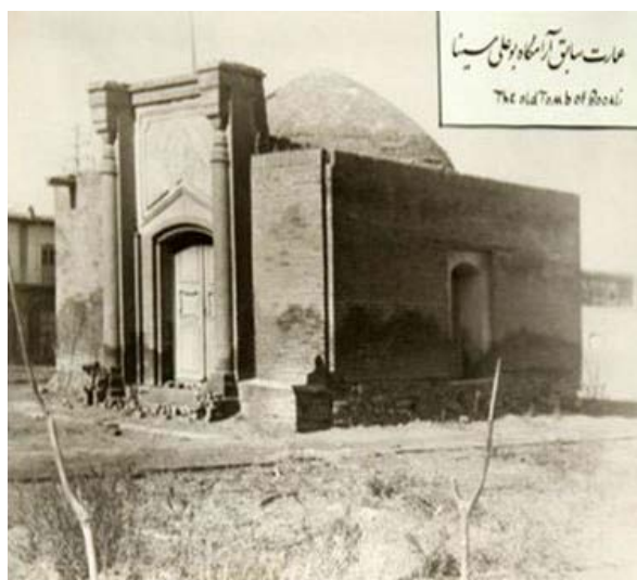
Мавзолей Абу Али Ибн Сина, Хамадан, Иран. Разрушен в результате землетрясения в 1950 г.
