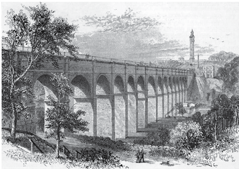
Рис. 7.6. Старый кротонский акведук, по которому вода из водохранилища Кротон поступала в город. После завершения его строительства в 1843 г. он поставлял ежедневно 40 млн галлонов питьевой воды (24).
