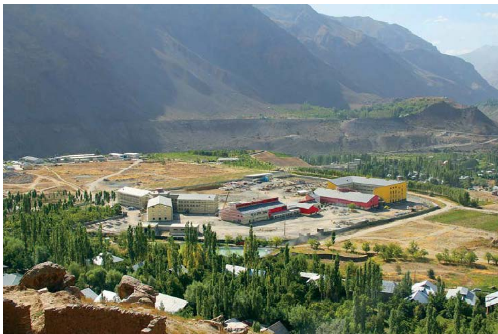
Рис. 10.7. Строящийся кампус УЦА в Хороге (2016), открытие которого состоится осенью 2017 г. Фото Х. Сулейманов, УЦА.
